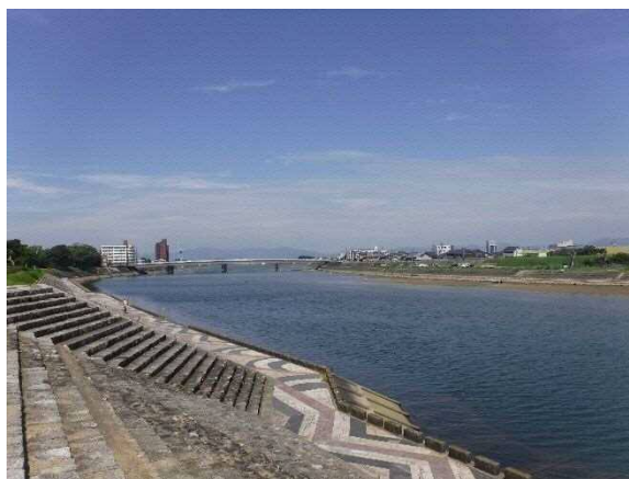
豊川下流域 吉田大橋付近 護岸
